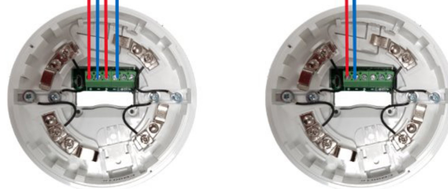
INIM ESB1010 kantasummeri ja ED100 ilmaisin - rappujen ylätasanteet
